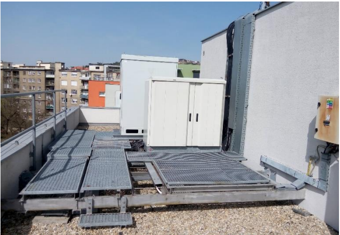
Po výmene technologického kabinetu
